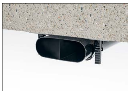
Canale piatto su solaio cantina
